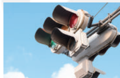
信号機設備工事
