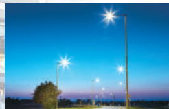
外灯取付工事
